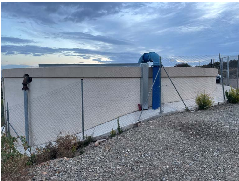
Fotografía nº2.- Exterior de depósito grande. Se observa la tubería con la que se hizo el by-pass para que llegara el agua sin pasar por el vaso del otro depósito
